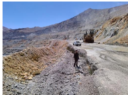
الف- نمونه‌ای از شکستگی‌ها در دیواره غربی تراز
