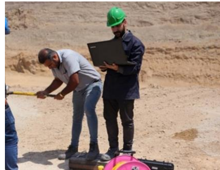
شکل ۹- عملیات لرزه نگاری درون‌چاهی
