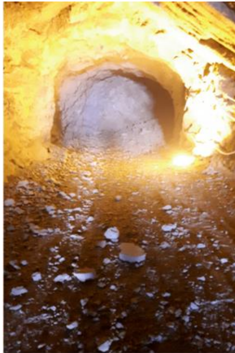
شکل ۱۵- پرتاب سنگ حاصل از انفجار با برش زاویه‌ای
