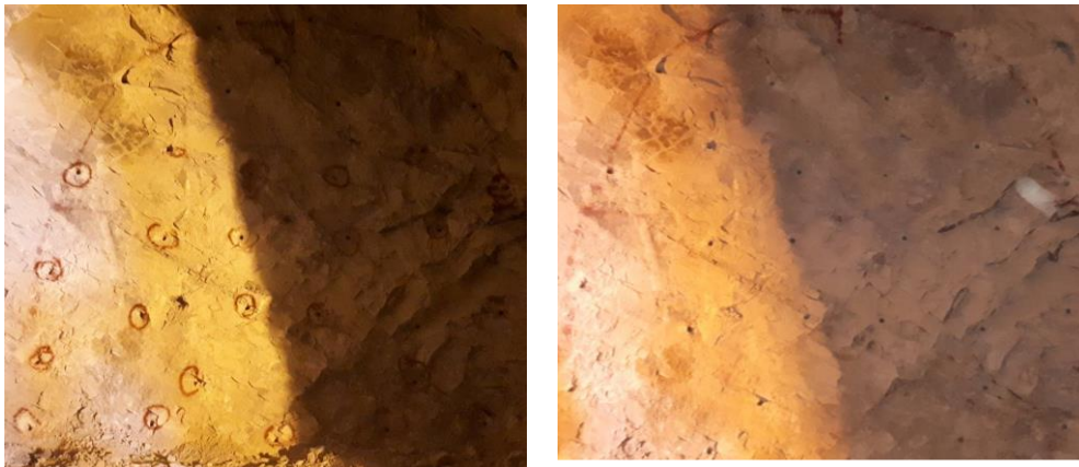
شکل ۱۷- اجرای الگوهای طراحی تونل سد نرگسی جدول ۷- نتایج حاصل از آتشفکری در تونل سد نرگسی
